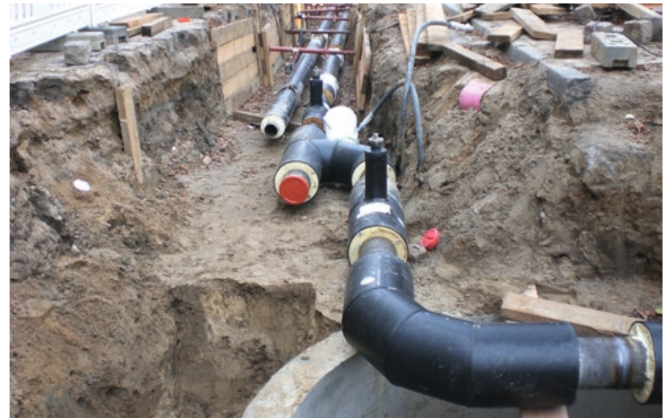
Verlegung von Fernwärmeleitungen in der Innenstadt
