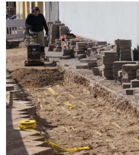
Auch nach Abschluss einer Baumaßnahme müssen wieder Warnbänder verlegt werden. Foto: SWS
