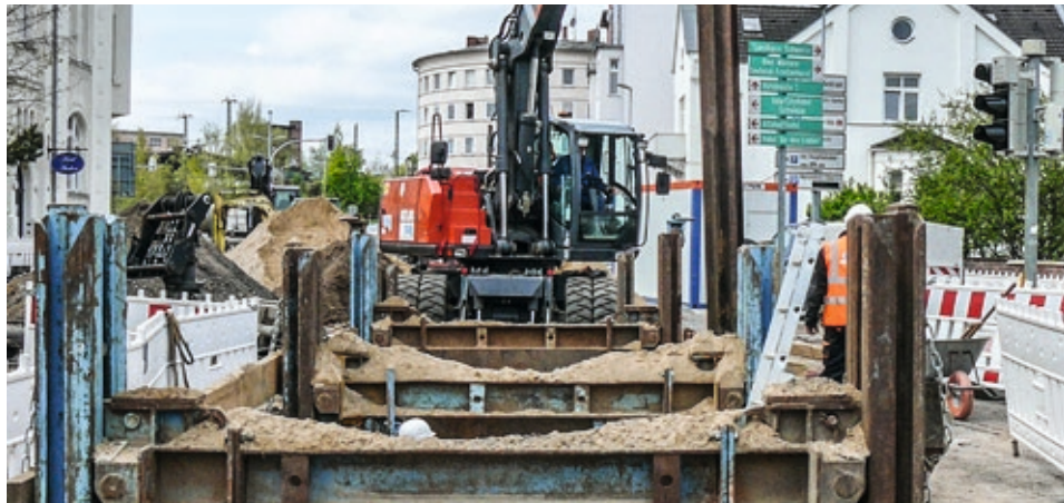
Bevor der Bagger zugreift, werden Sicherungsmaßnahmen, beispielsweise Freischaltungen, durch den Netzbereich festgelegt.
