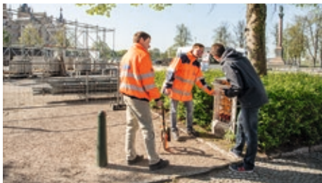
Einweisung zur Stromversorgung für die einzurichtende Baustelle Foto: SWS
