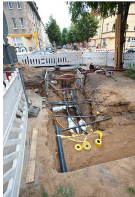
Herstellung von Hausanschlüssen
