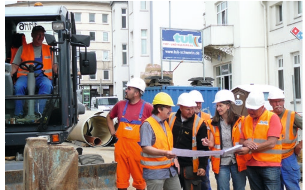
Baubesprechung am Bürgermeister-Bade-Platz
