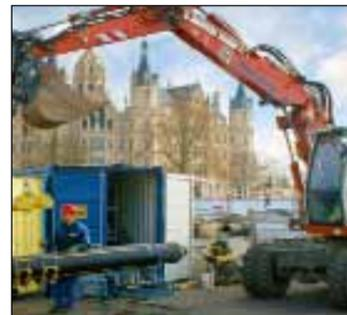
Die zwei Fernwärmeleitungen wurden mit einer speziellen Bohrtechnik unter dem Alten Garten und dem Burgsee verlegt Foto: SWS
