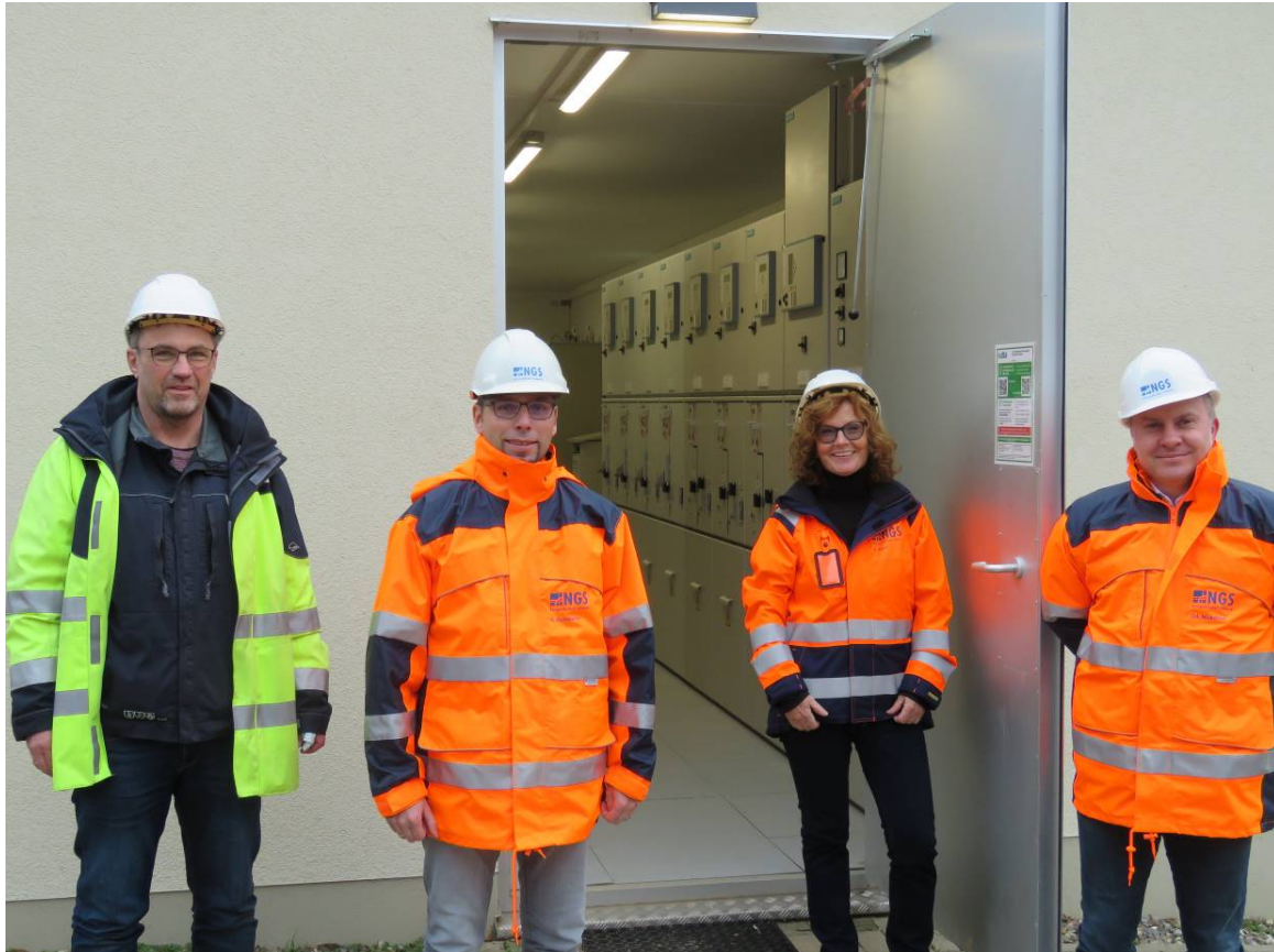
BU: Das Team der Netzgesellschaft Schwerin mbH (NGS) nahm die neue Mittelspannungsschaltanlage auf dem Großen Dreesch in Betrieb v.l.: M. Fentzahn, Netzmeister Strom; S. Ochmann, Netzingeneur Strom; S. Koch Geschäftsführerin NGS; C. Nickchen, Geschäftsführer NGS
