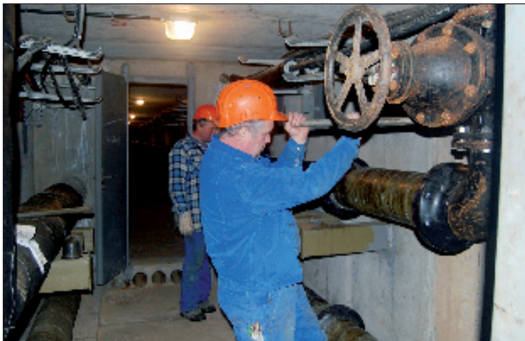
Seit rund 30 Jahren arbeiten Horst Warnke (vorn) und Arthur Falow als Rohrnetzmonteure. Einer ihrer Arbeitsorte: die Kollektoren unter dem Großen Dreesch Foto: maxpress/ja
