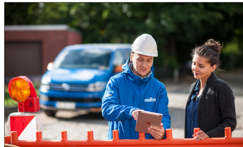
Jeder Schritt beim Glasfaserausbau ist für den Kunden digital nachvollziehbar Foto: SWS
