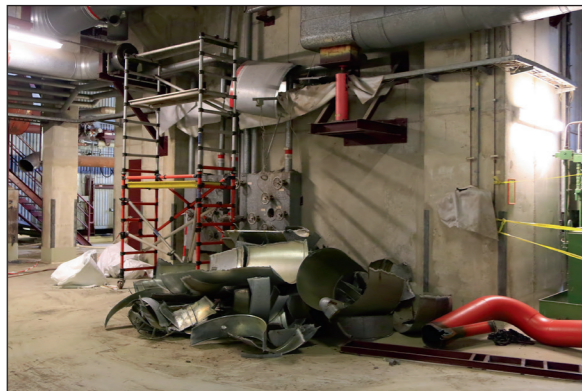
Vor allem thermisch hochbelastete Baugruppen werden im HKW Süd ersetzt Fotos: Stadtwerke
