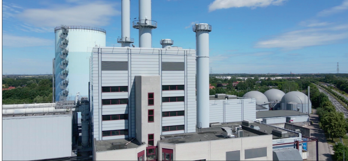
Nach dem umfangreichen Umbau des Heizkraftwerkes zählt Schwerin zu den modernsten Standorten in Europa
