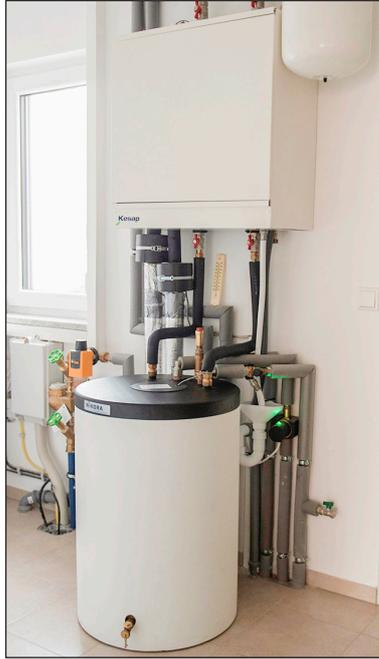
Fernwärme-Kompaktstation mit Warmwasserspeicher Foto: Stadtwerke Schwerin
