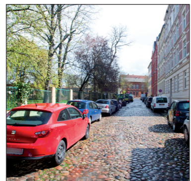
Im östlichen Bereich der Hospitalstraße wird ab Anfang Mai gebaut. Foto: maxpress/jk
