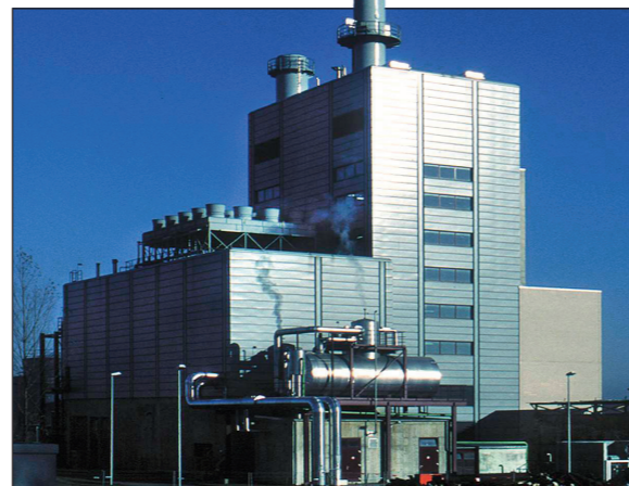
Mit dem Heizkraftwerk in Lankow wurde die Emissionsbelastung in der Landeshauptstadt deutlich reduziert
