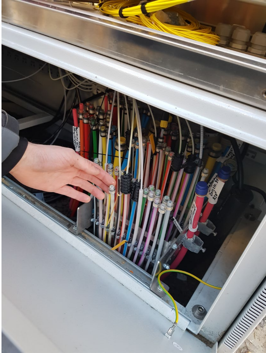
BU: Ankommende Glasfasern im Multifunktionsgehäuse (MFG)
